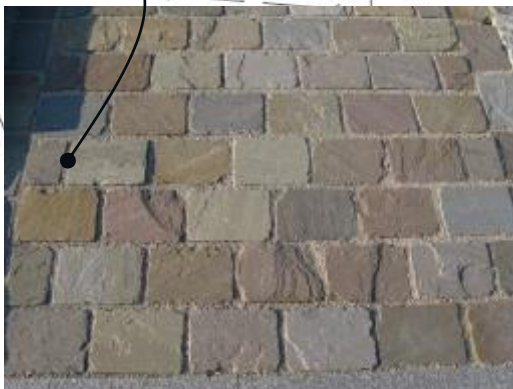
Pavés grès sur entrées charretières, Caniveaux et Bordures en grès
