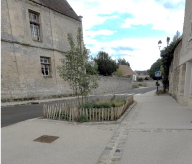
Exemple Moussy : requalification de la traversée de village : béton désactivé sur les trottoirs avec plantations en pleine terre délimitées par bordures grès, protection par ganivelles en bois
